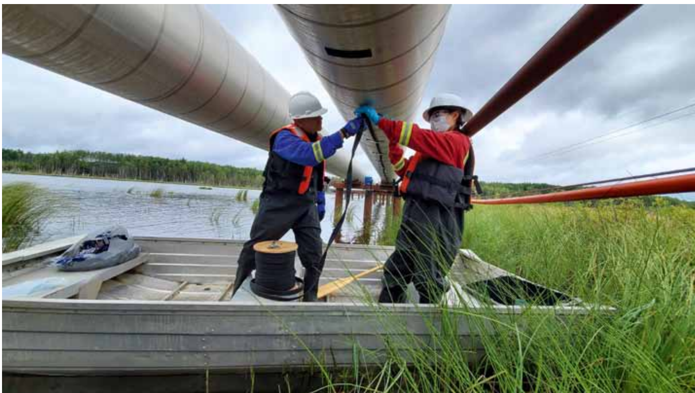
WrapSense placeras vanligtvis på undersidan längs ett rör där eventuella läckor kommer att samlas och på speciellt kritiska platser, till exempel över en sjö.
