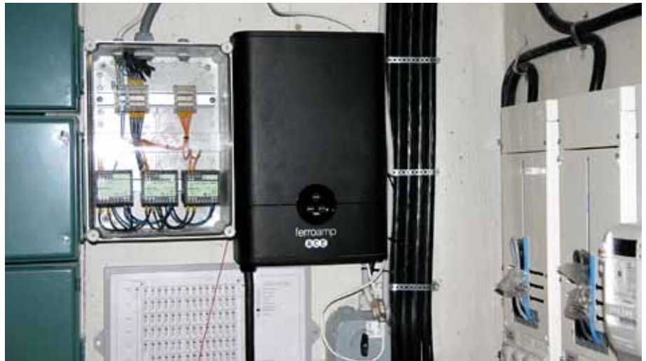
Svenska Ferroamps batterisystem för energilagring och energistyrning.
