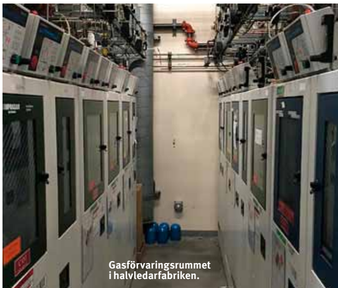
Gasförbrukningen avläses i realtid. Värdena sänds trådlöst till anläggningens programvara som förutser hur gasen ska fyllas på och även hjälper till med kapacitetsplaneringen.
