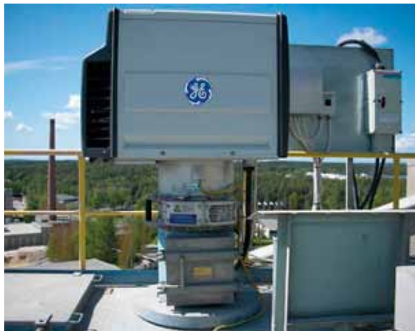
Ett kraftaggregat på toppen av det elektrostatiska filter som syns i illustrationen på föregående sida. På bilden till höger går det att få en skymt av elektroniken i ett kraftaggregat.
